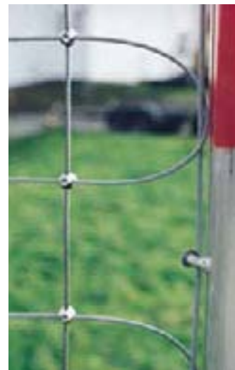
Détail du montage anti-vol par câble transfilé
